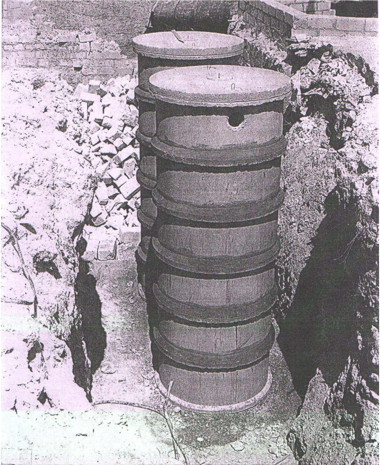
IMPIANTO FOSSE IMHOFF ESEGUITO IN BATTERIA
